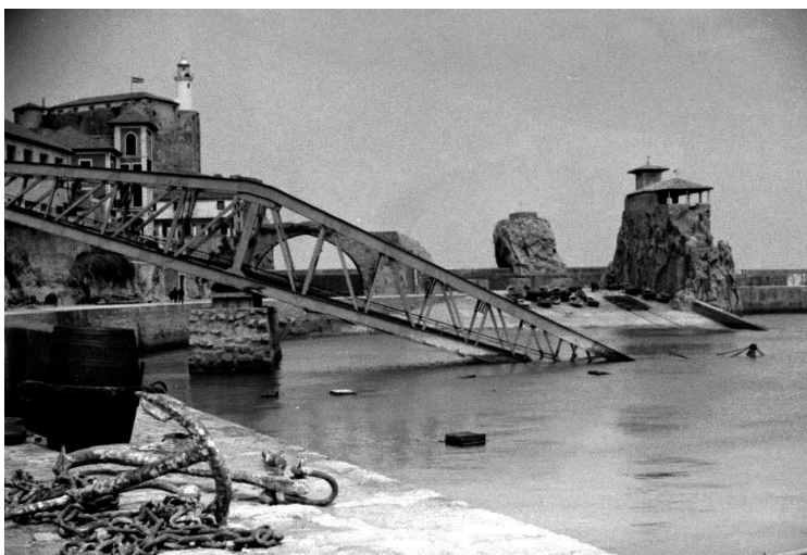
Cargadero de Alén, lugar elegido para levantar la Fábrica de Hielo. Fot. Deschamps, año 1937.
