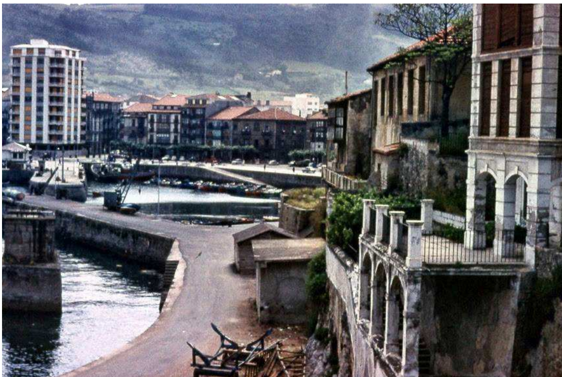
Machón del Cargadero, el lugar para emplazar las instalaciones del hielo. Fot. Ramos.
